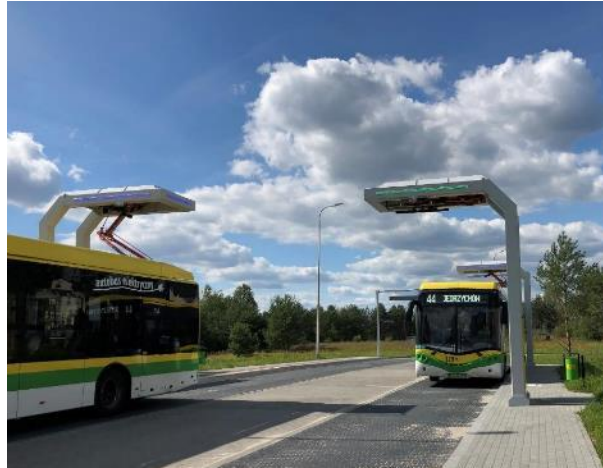
Rys. 4.8 Ładowanie autobusu elektrycznego akumulatorowego z ładowarki pantografowej
